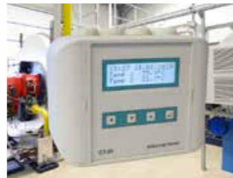
SMART-BOX Moderne Gehäusereihe mit hoher Schutzart bis IP66 für robuste Anwendungsbereiche.
